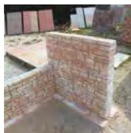
Nous vous conseillons de réaliser vos murets de jardin en posant les blocs à plat (largeur = 15 cm). Si muret > ou = à 50 cm alors prévoir un coffrage pour retenue de terre. Dans tous les cas, le maximum de hauteur pour une stabilité certaine est limité à 1 mètre.
